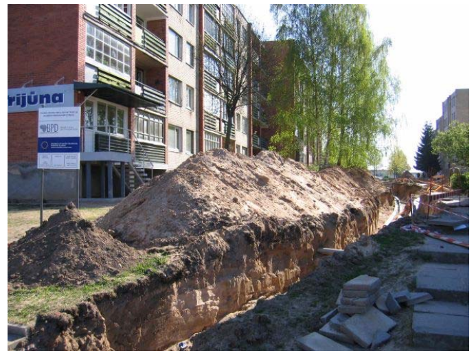
Ruošiamasi demontuoti senus vamzdžius Utenoj (iš www.lvpa.lt )
