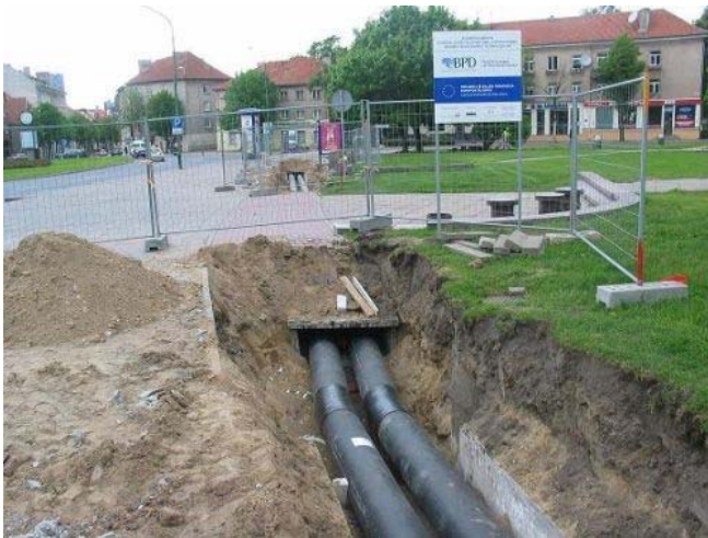
Kretingoj patiesti nauji, izoliuoti garotiekiai (iš esparama.lt )
