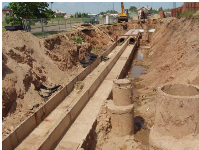
Demontuojami seni vamzdžiai Panevėžy (iš www.lvpa.lt )
