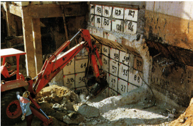
Reikia pašalinti radiaciją nuo elektrinės sienų (iš nrc.gov)
