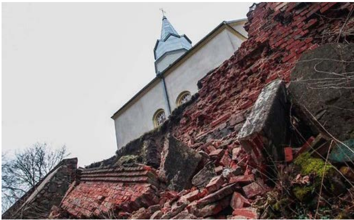
Sugriuvo siena, kuri sulaiko šlaitą. (15min.lt nuotr.)
