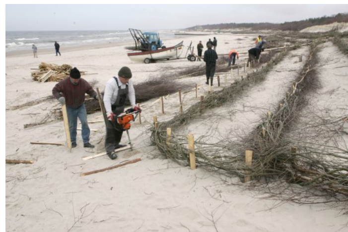
Palangoje prie kopų pakraščio tiesiamos išpintos žabtvorės . (veidas.lt nuotr.)
